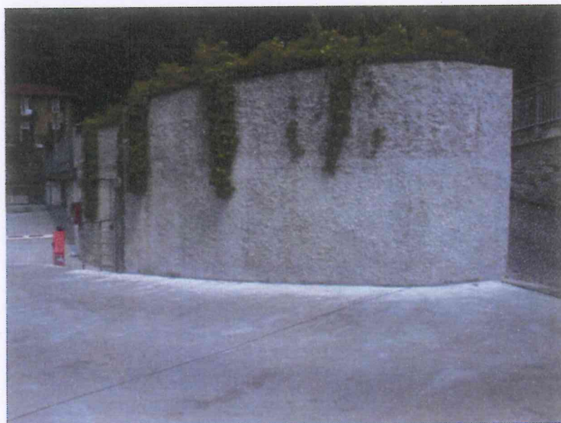
Tratto muratura in cui posizionare il nuovo corrimano
