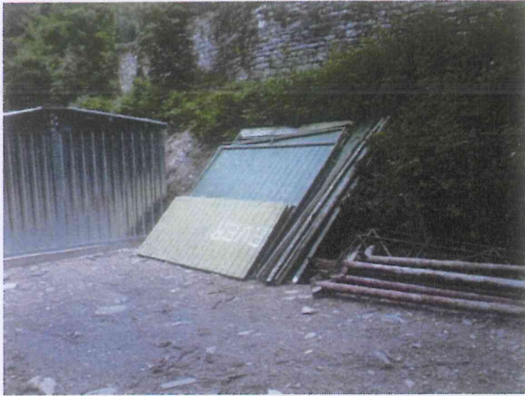
Scarpata in prossimità nuova baracca
