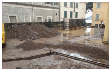
Intervento di pulizia dei detriti in frazione Girola dopo l'alluvione dello scorso Ottobre
