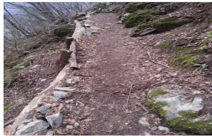
Ripristino di tratto del sentiero Brunate – Monte Piatto
